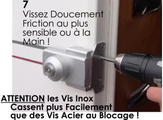
Après Perçage, si vous Constatez ne pas avoir de Structure: Percez à Ø 4 et Fixez avec des Rivets Ø 4 X 10
